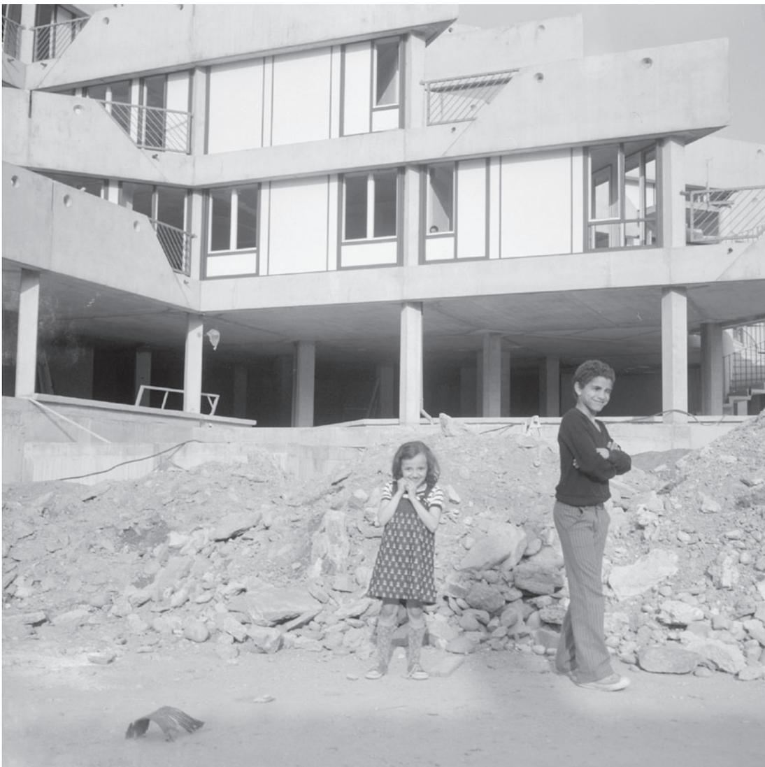
>>> Le système structurel des édifices se compose de poteaux et de dalles porteurs en béton. Les façades sont constituées d'éléments préfabriqués rapportés à cette structure : baies, allèges, garde-corps et panneaux de remplissage légers.
