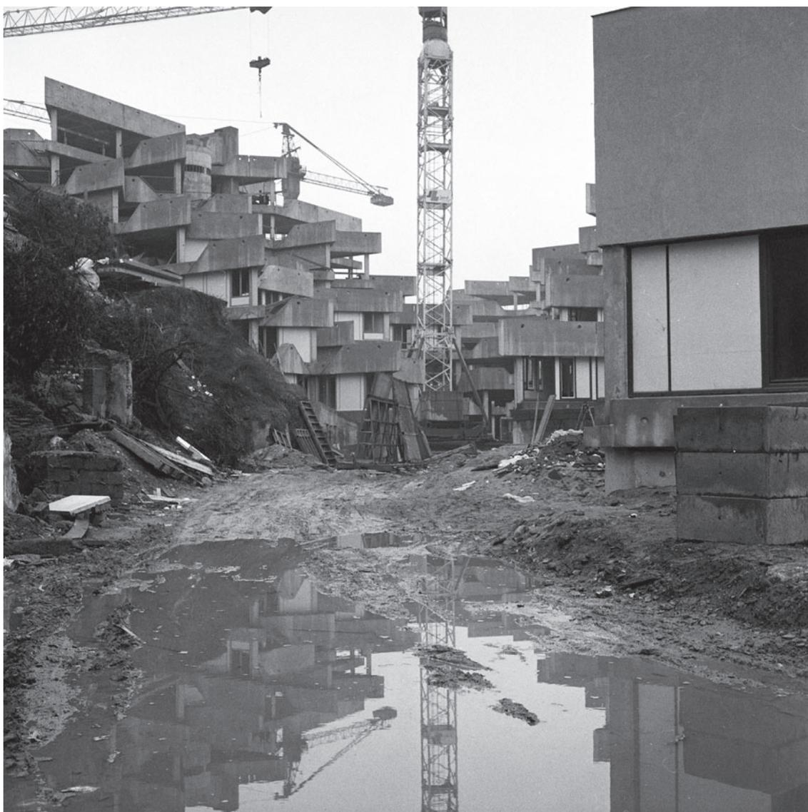
Les panneaux de façade sont montés après la réalisation de l'ossature du bâtiment; cette décomposition des ouvrages permet d'avancer plus rapidement la réalisation de la structure et de réduire à une opération de montage à sec la réalisation des allèges et des garde-corps.
